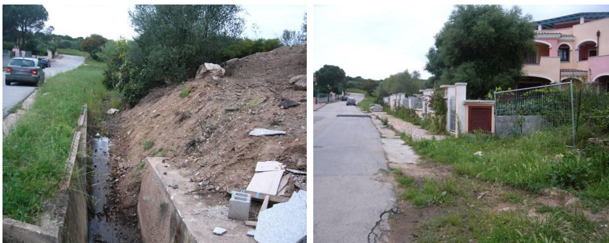
Fig. 18- Esempio di ratto a deflusso critico in parte tombato in via degli Iris monte Via Conca Caddinas.
